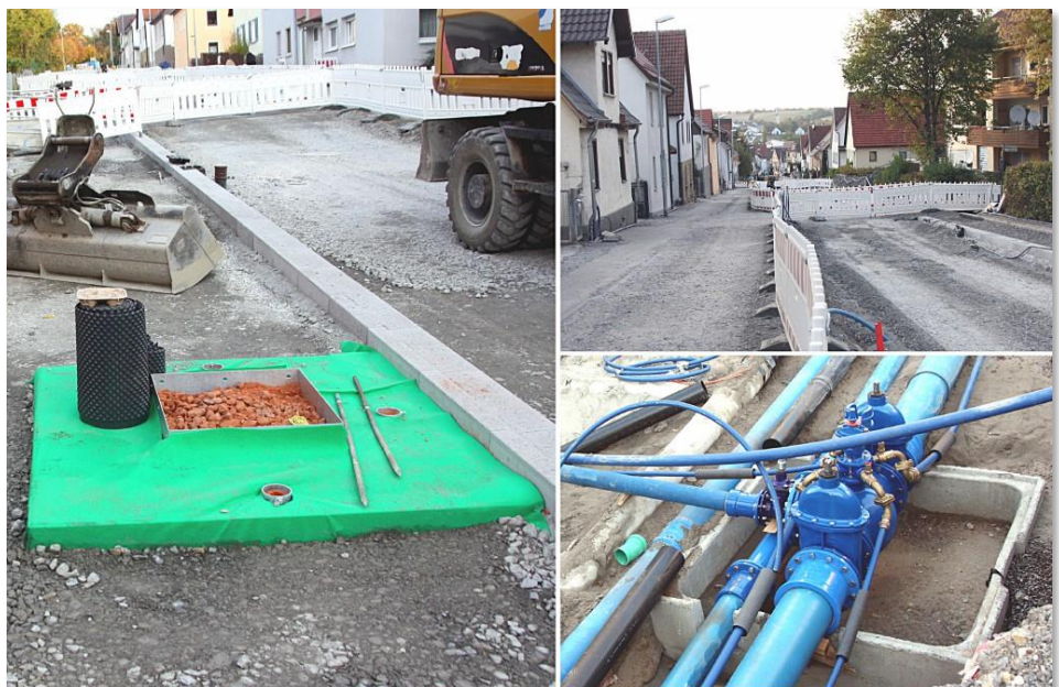
Baumquartier, neue Randsteine, halbseitiger Baufortschritt und neue Leitungstechnik Weitere ausführliche Bildergalerien zur Baustelle finden Sie auf der ABG Internetseite .
