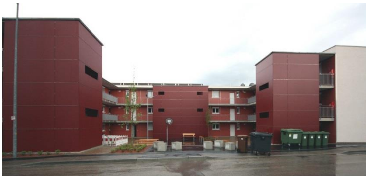
Das großteils fertiggestellte Gebäude mit gestaltetem Innenhof
