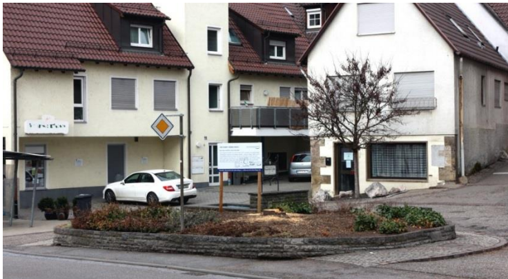
Das erste Anzeichen für den Beginn der Sanierung der Ortsdurchfahrt: Die Linde am Vaux-le-Pénil-Platz ist gefällt
