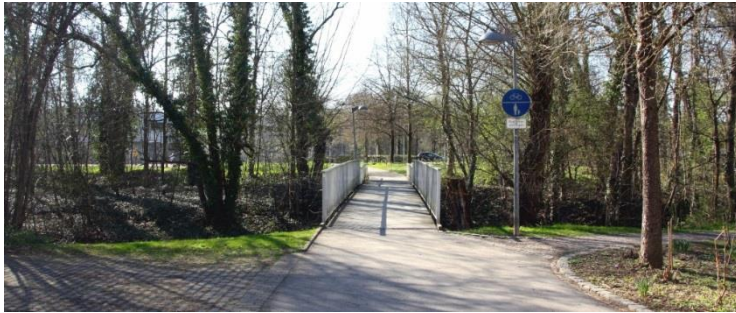
Diese Fußgängerbrücke in Richtung Turn- und Festhalle wird mit einer Behelfsbrücke überbaut
