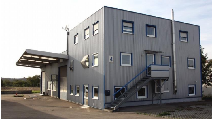
Das Gebäude im Felsenbergweg Nr. 4 im Oktober 2016
