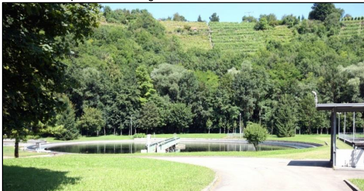
Das große Nachklärbecken ist wieder voll im Einsatz
